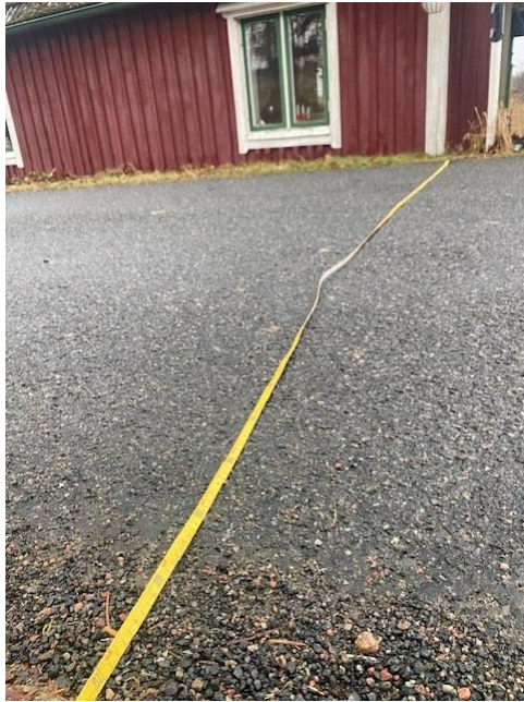
Bild 4. Vägbredd, 3,70. Ny beläggning Jim-massa, sten i tjära
