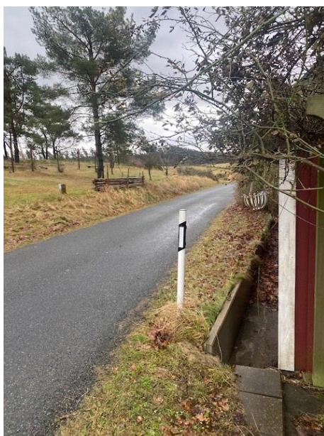
Bild 3a. Hus nära vägen, L-stöds kant som vägföreningen anlagt
